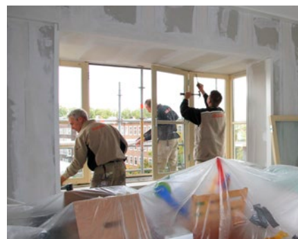
↑ Het monteren gebeurt in droogbouw: sneller én schoner!
